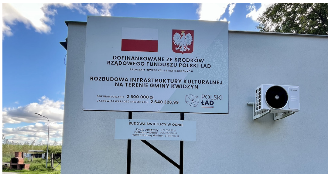
Fotografia 9. Nowy budynek powstającej świetlicy w Ośnie. Źródło własne
